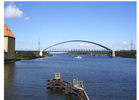
Most na rychlostní silnici S3 ve Wolini, nedaleko Štětína
