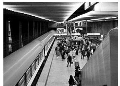
Warszawa Centralna, hlavní nádraží v Polsku, otevřené v roce 1975. Nástupiště jsou kompletně v podzemí
